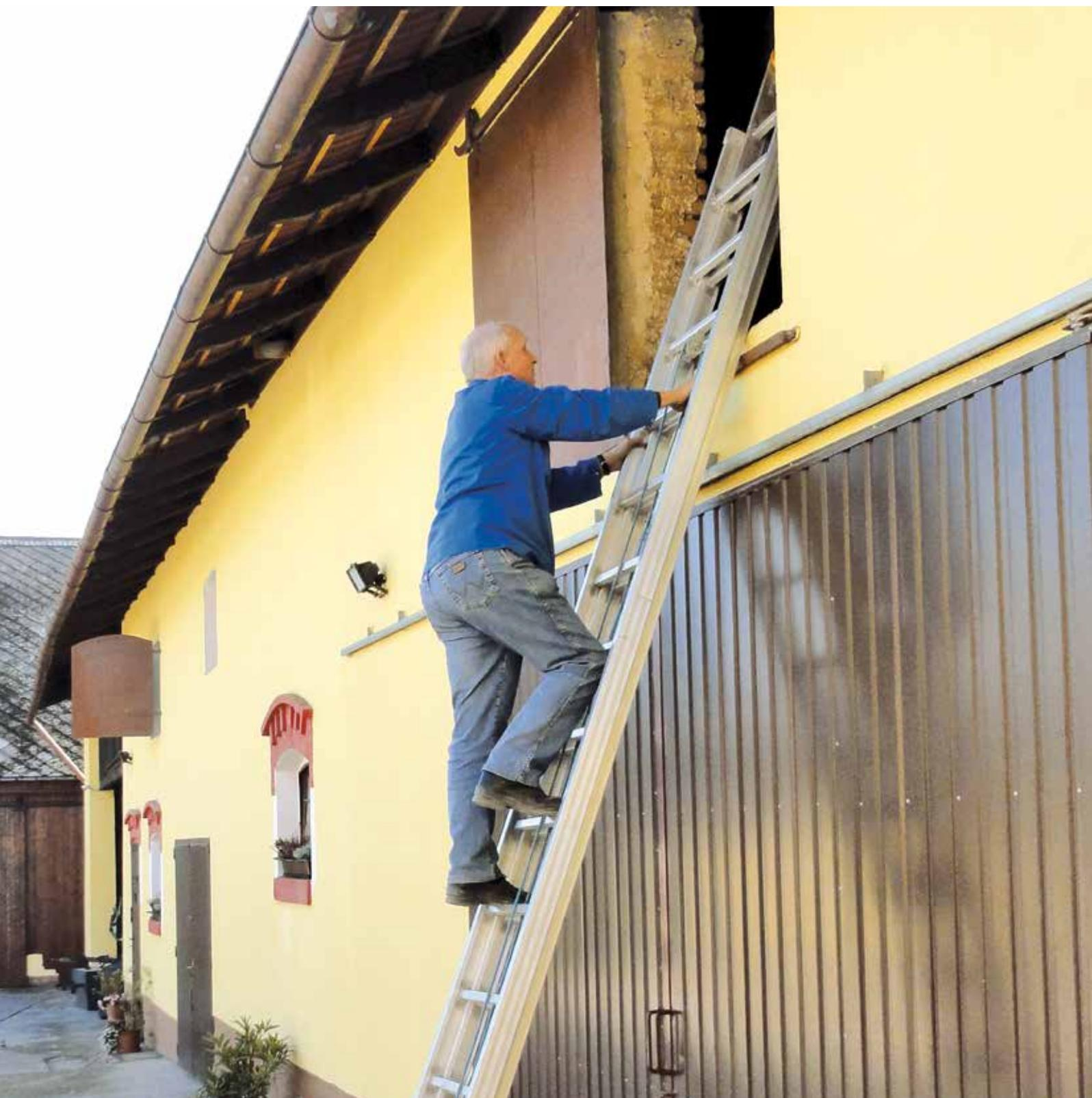
Leitern sind oftmals notwendig, wenn aus baulicher oder arbeitstechnischer Sicht keine Stiege eingebaut werden kann, um von einer Arbeitsebene auf eine andere zu gelangen, bei kurzfristigen Instandsetzungsarbeiten an Wirtschaftsgebäuden und auch bei der Obsternte. Bei längerfristigen Arbeiten sind Gerüste oder Arbeitsbühnen zu verwenden. Ungesicherte oder schadhafte Leitern stellen eine Unfallgefahr dar.
